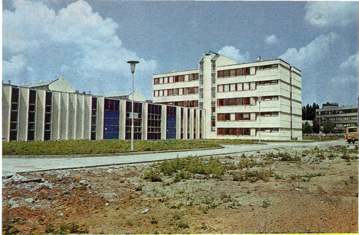
Az 1981-ben átadott műhelycsarnok és laborépület
